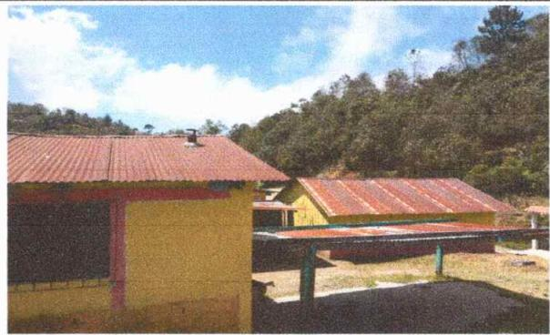
Foto 4: Sustitución de lámina por lámina troquelada
