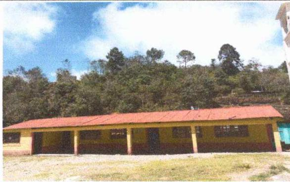
Foto 3: Sustitución de lámina por lámina troquelada y cambio de parales por costaneras
