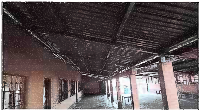
Foto 4: Corredor, Techo, láminas y vigas nuevas.
