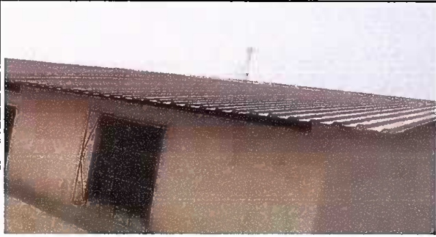
Foto 1: Bodega. Techo, láminas y vigas nuevas.
