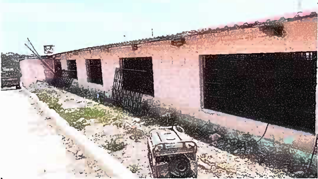
Foto 3: Aula No. 1 y 2 En proceso de instalación de nueva estructura de ventanas, mas vidrio y balcones,
