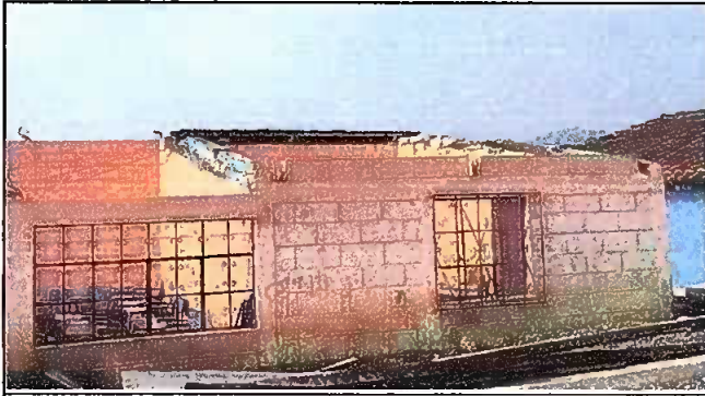
Foto 1: Bodega. Desmantelación del techo.
