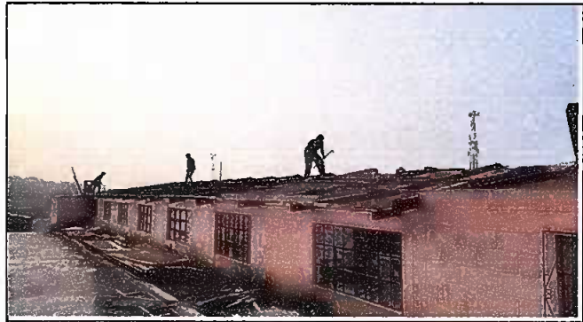
Foto 2: Aula No. 1, 2, 3, 4 Desmantelación del techo.
