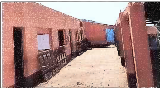
Foto 5: Aula No. 1 y 2 Desmantelación de de ventanas.
