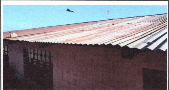
Foto 2: Aula No. 1, 2, 3, 4 y 5 Cambio de techo, láminas y vigas en mal estado.
