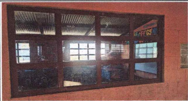
Foto 5: Aula No. 1 y 2 Cambio de estructura de ventanas parte frontal, madera en mal estado.
