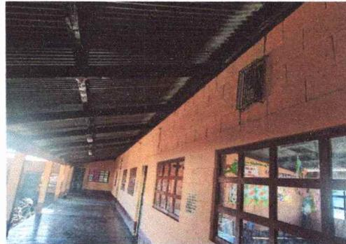
Foto 4: Corredor, cambio de techo, láminas y vigas en mal estado.
