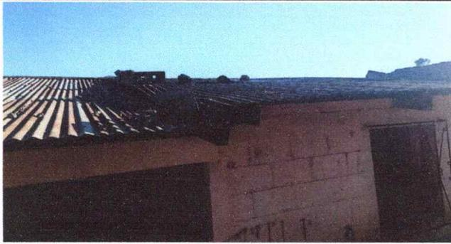
Foto 1: Bodega. Cambio de techo, láminas y vigas en mal estado.
