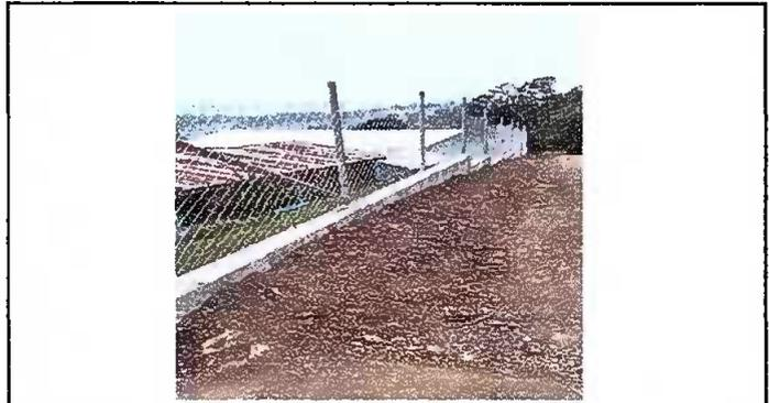
Foto 5: Muro perimetral y maya en mal estado
