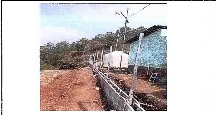
Foto 3: Sustitución de maya por muro perimetral de block
