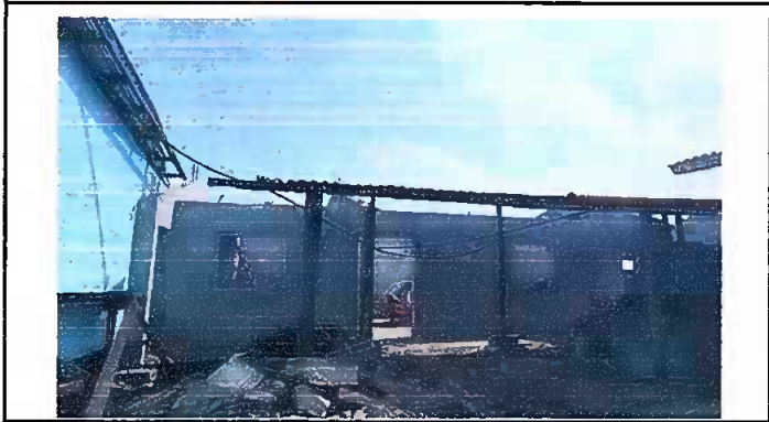
Foto: Cambio de techo
