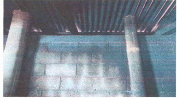
Foto: Cambio de chimenea
