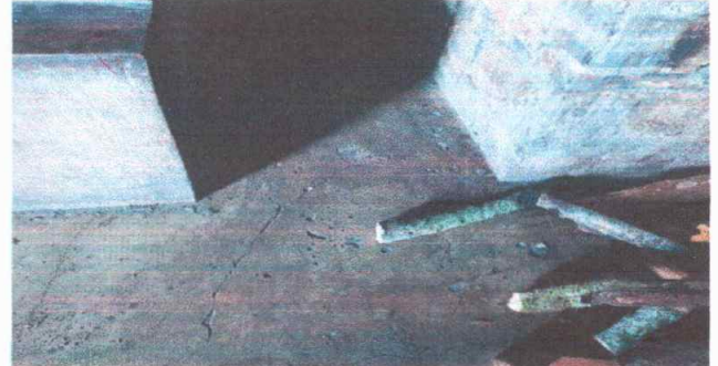
Foto: Susicucion de piso ceramico
