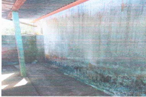
Foto Ampliación de cocina
