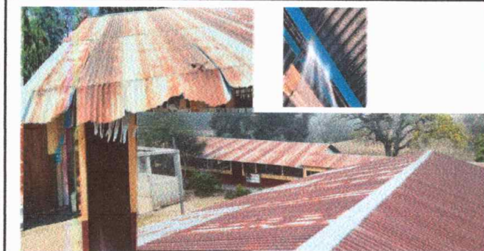
Foto 1: Cambio de laminas
