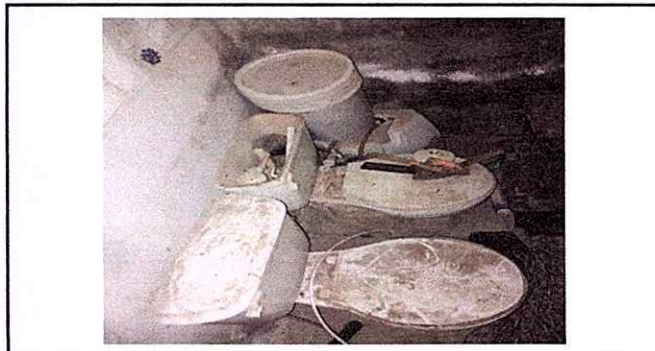
Foto 6: Sustitución de accesorios para sanitarios
