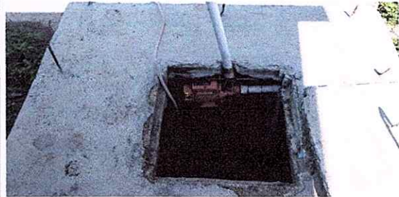
Foto 10: Sustitución de bomba de agua
