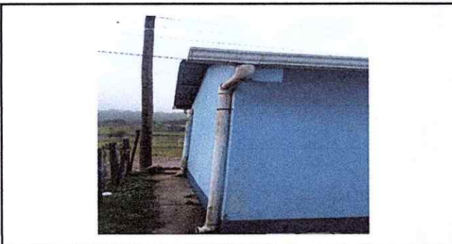
Foto 5: Sustitución de tubería de bajada pluvial
