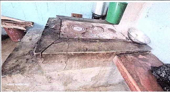
Foto 1: Susitución de estufa y colocación de azulejo
