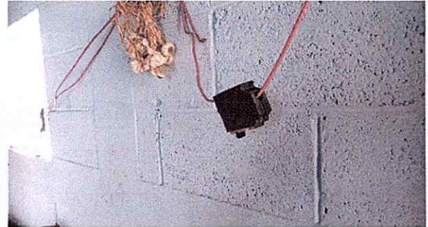
Foto 8: manteminiento de pozo, limpieza tapadera, conección eléctrica
