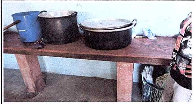
Foto 2: Reparación de azulejo en muebles de cocina
