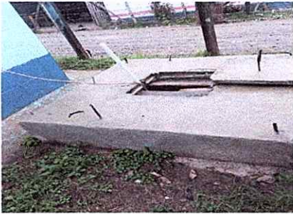
Foto7: manteminiento de pozo, limpieza tapadera, conección eléctrica
