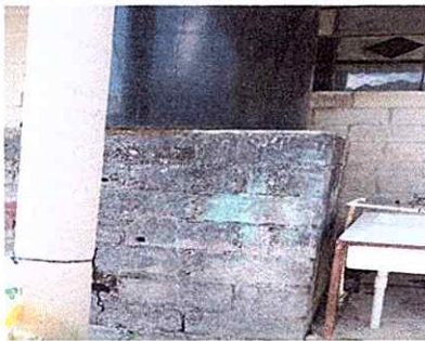
Foto 11: Repello de base del depoósito de agua
