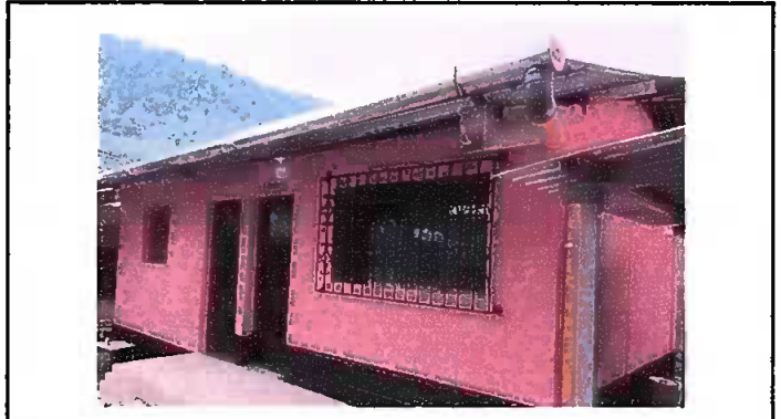
Pintura de cocina, balcones y colocación de canales
