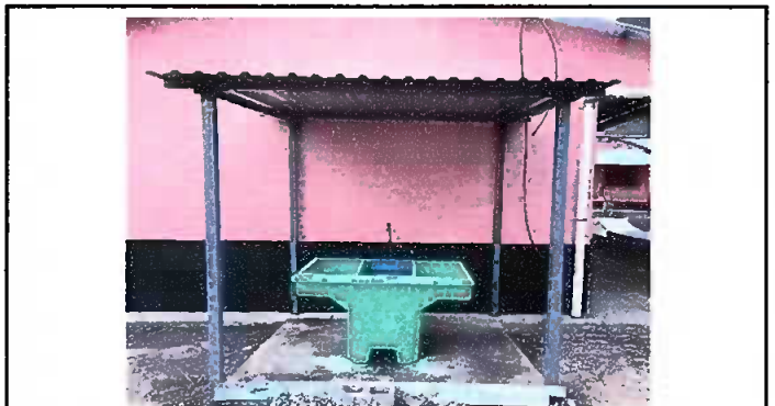
Estructura metalica, pintura y torta de cemento para pilas
