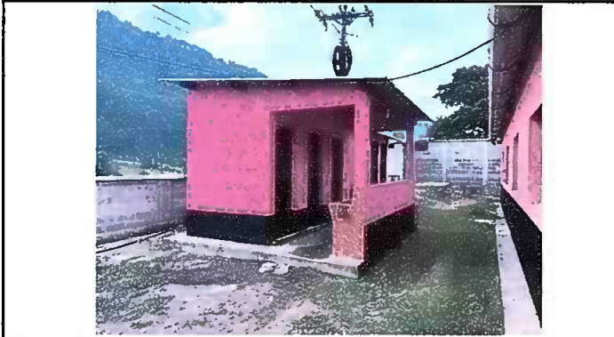
Pintura y cambio de respuestos para baños
