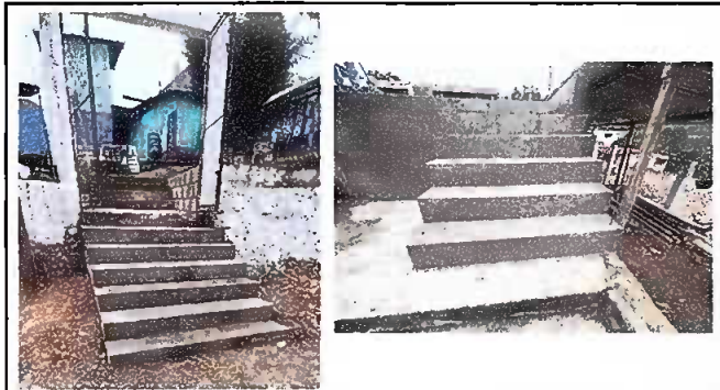
MODULO: 3 Reparación de gradas.
