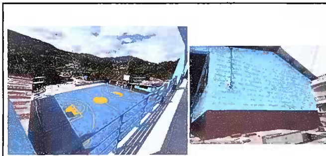
MODULO: 5 Impermeabilizador de humedad dentro del aula y retoque de pintura dentro y fuera de toda la escuela.
