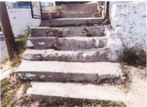
MODULO: 3 Reparacion de gradas.
