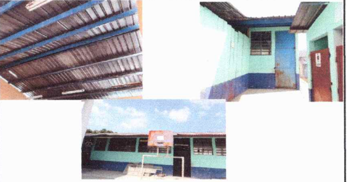
MODULO : 4 Sustitucion de candelas Led y bases.
