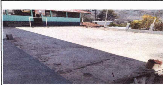
MODULO: 1 Reparación de piso de torta de concreto y centracion de porteria, tablero y marcaje de cancha.
