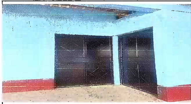
Aula No. 6 y 7: Estructura (lijado y aplicación de pintura y chapas )
