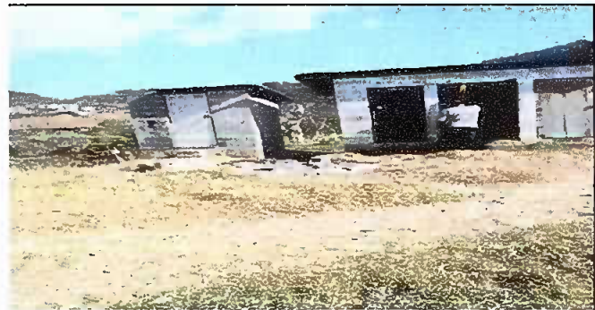
Baños: Lámina troquelada, estructura de metal y puertas en servicios sanitarios
