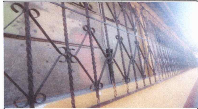
Aula No. 5 y 6: Sustitución de vidrios y mantenimiento de balcones de metal
