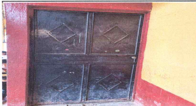
Aula No. 5: Sustitución de puerta
