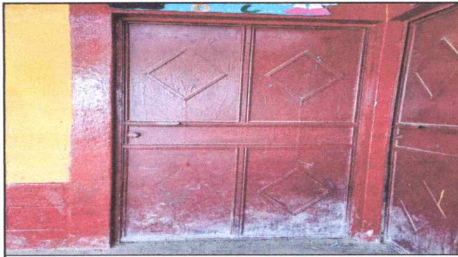
Aula No. 6 y 7: Mantenimiento a estructura (lijado y aplicación de pintura y sustitución de chapa).
