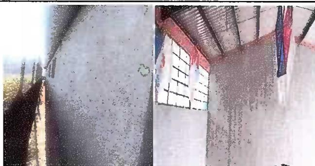
Foto No.9. Aulas en mal estado. Repello en mal estado.
