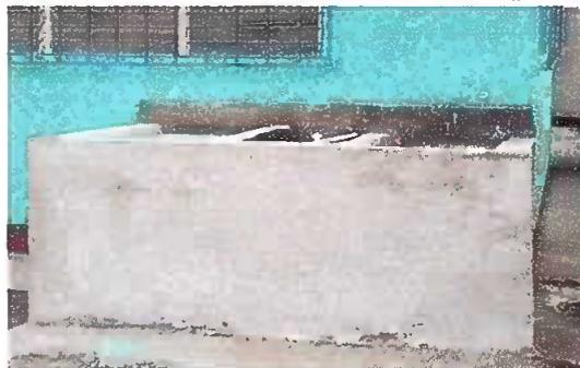
Foto No.8. Cambio de pila de plástico por una pila formal.
