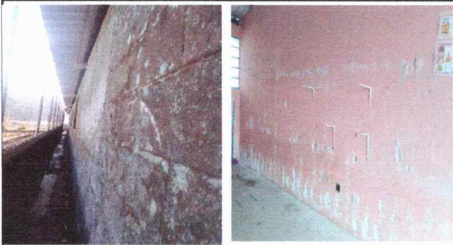
Foto No.9. Aulas en mal estado. Repello en mal estado.
