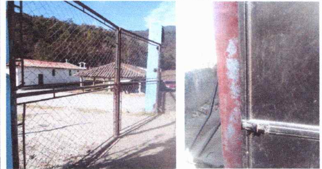
Foto No.2. Sustitucion de porton de rejas en mal estado por un porton formal de barrotes y sustitución de puestas de los sanitario en mal estad
