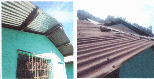
Foto No. 1. Bodega de Alimnetos. Cambio de laminas y vigas en mal estado
