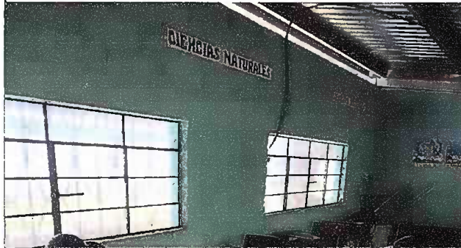
Foto No. 1: Aula No.2 ventanas instaladas, módulo 1
