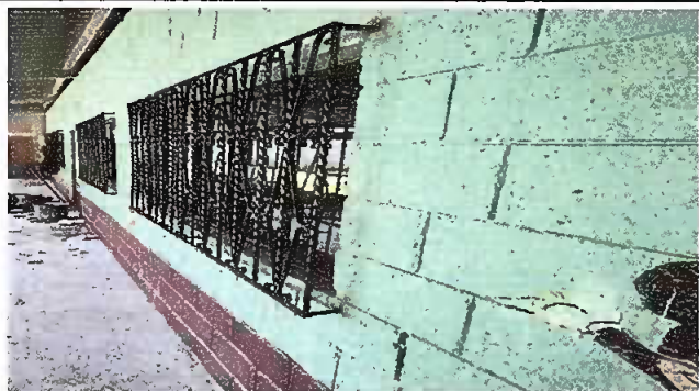
Foto No. 1: Aula No.2 instalando ventanas, módulo 1
