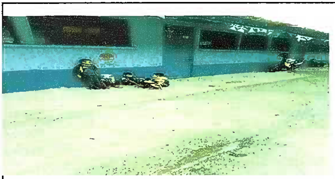
Foto 6: Reparacion de piso de torta de concreto en el corredor.
