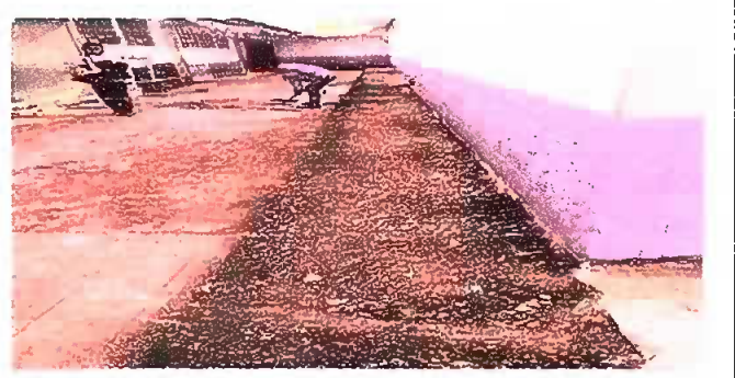
Foto 6: Reparacion de piso de torta de concreto en el corredor. 1,2,3,4,9, 10 y 11.
