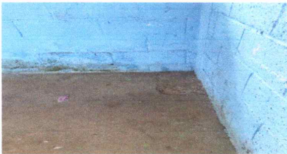
Foto 5: Sustitución de piso torta de concreto por piso ceramico en aulas 1,2,3,4,9, 10 y 11.
