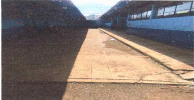
Foto3: Reparación de piso de torta de concreto en el corredor
