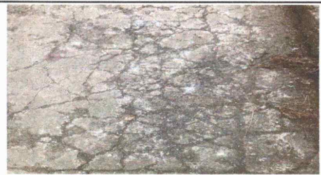
Foto2: Reparación de piso de torta de concreto en el corredor
