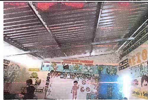
Foto 4: Situación de costanera en buen estado edificio 1 parte alta
