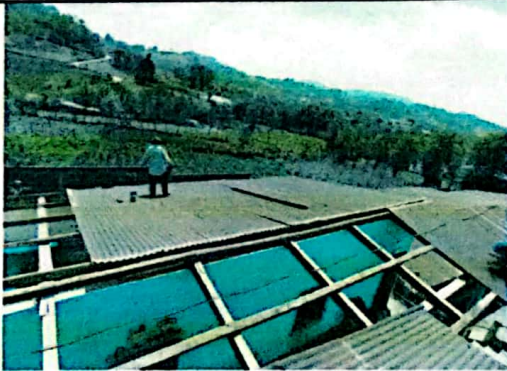
Foto 3: Situación desentechando edificio uno parte alta.
