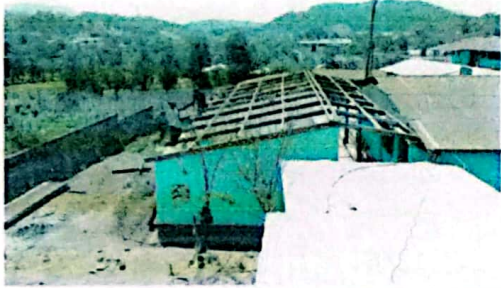
Foto 1: Situación techo remosando edificio uno parte alta.
