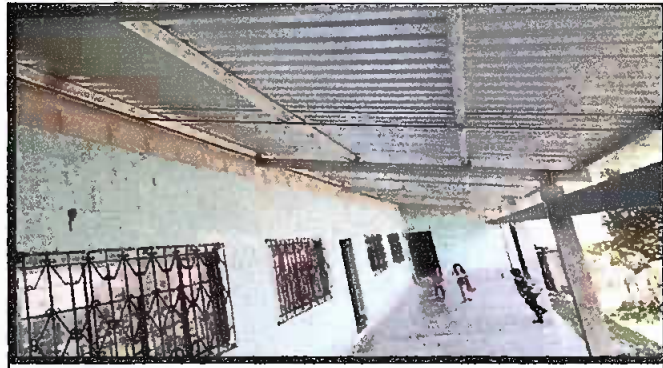
Foto 2: Modulo 1 cambio de lámina y estructura de soporte
