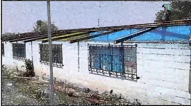
Foto1: Sustitución de lamina por lamina aluzinc calibre 26
