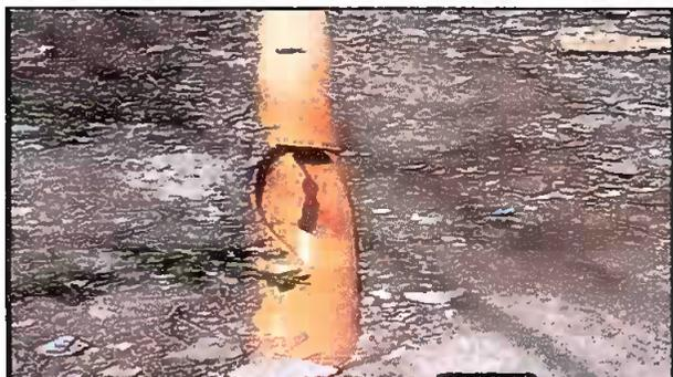
Foto 4: Modulo 3 cambio de tubería de aguas negras, de los baños de la escuela, a la fosa septica
