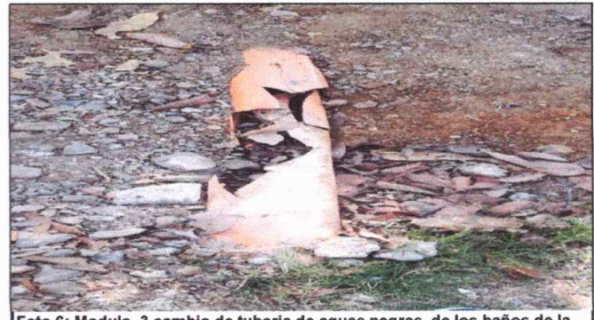
Foto 6: Modulo 3 cambio de tubería de aguas negras, de los baños de la escuela, a la fosa séptica
