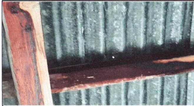
Foto1: Modulo 1 cambio de lámina y estructura de soporte
