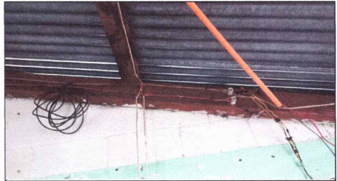
Foto 4: Modulo 2 cambio de instalación eléctrica donde se va a cambiar el techo
