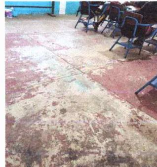
Foto 4: Sustitución de piso cemento liquido a pisode granito en aulas 8 y 9.
