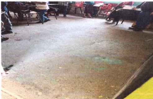
Foto 3: Situación piso de torta de concreto a piso de granito en aulas 3 y 4.
