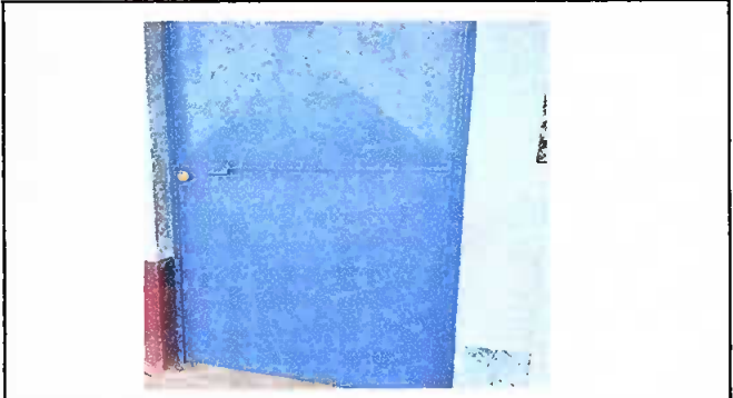
Foto 4: puerta pintada y chapa nueva
