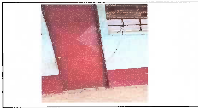
Foto 5: puerta pintada y chapa nueva
