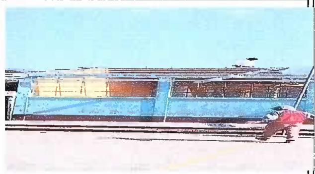
Foto 2: Instalando estructura metalica y lámina
