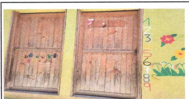
Foto 6: Sustitución de puertas
