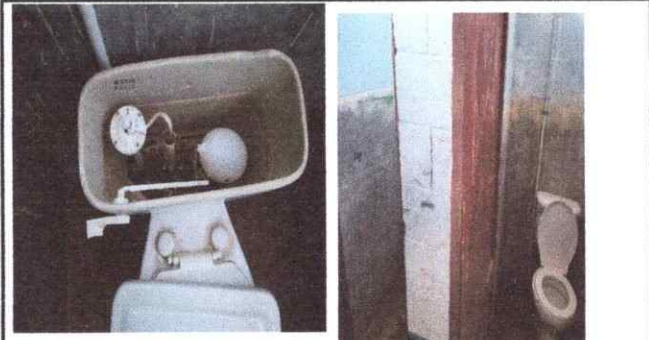
Foto 4: Sustitución de inodoros.
