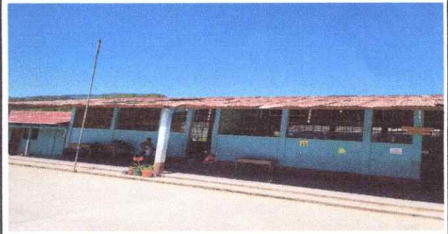
Foto 2: Sustitución de techo.
