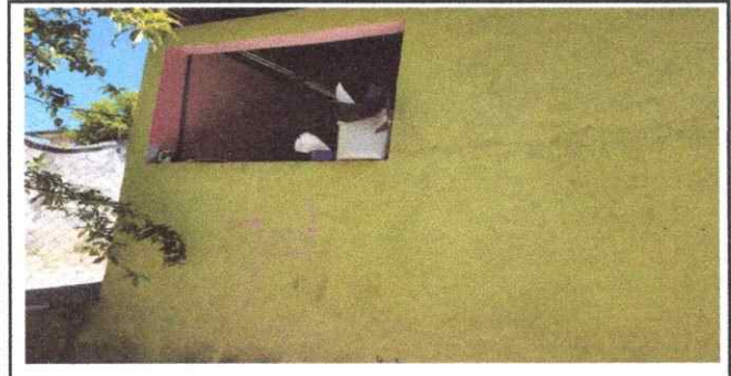
Foto 3: Sustitución de ventana.
