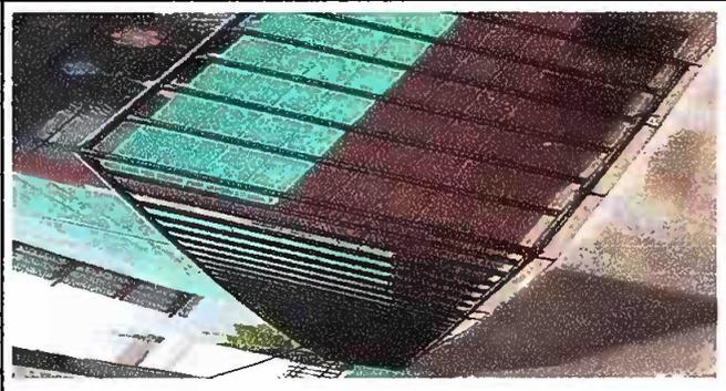
Foto 8: cambio de rampa de madera por metal.
