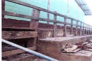
Foto 8: cambio de rampa de madera por metal.
