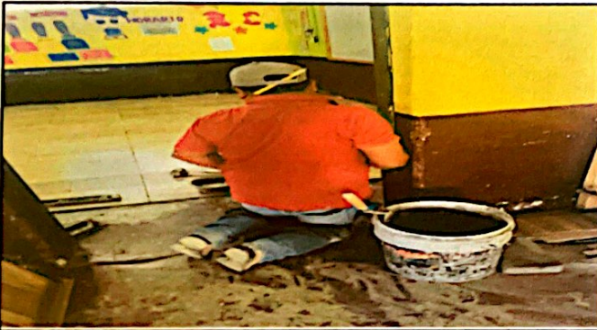
Foto 3: Estado del piso de la aulas
