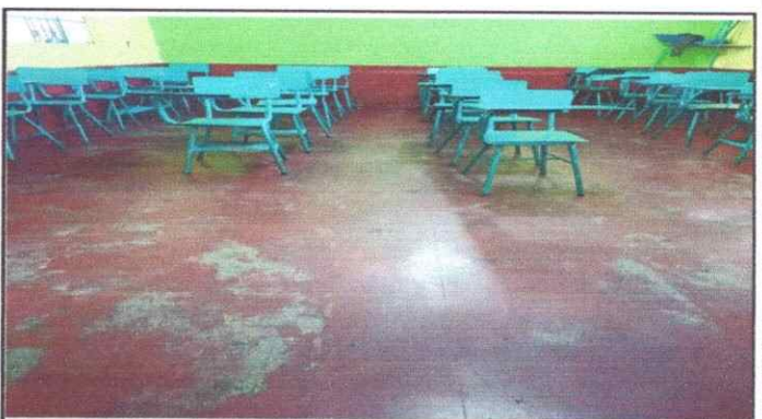
Foto 4: Cambio de piso aulas
