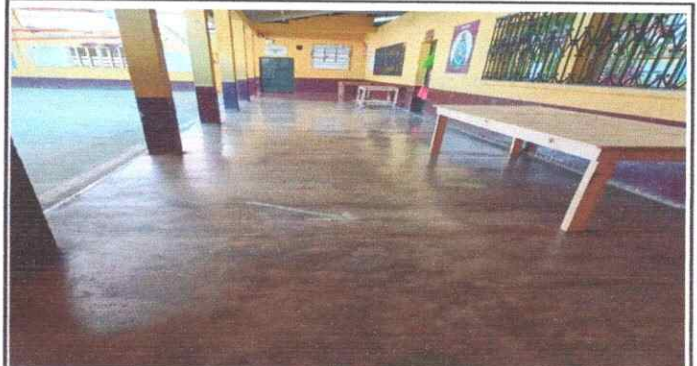
Foto 2: Cambio de piso corredor 2
