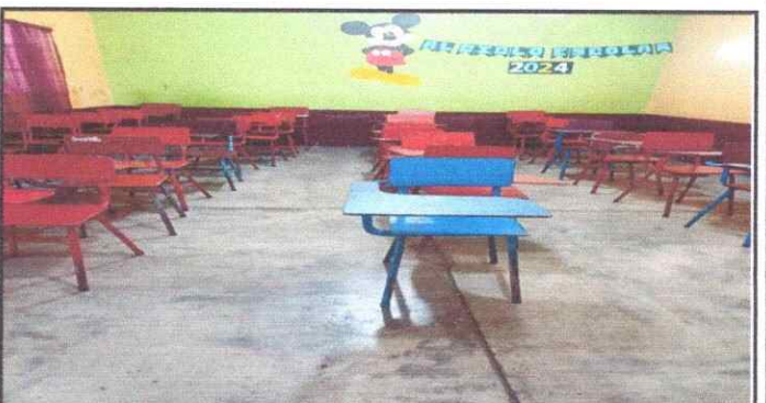
Foto 6: Cambio de piso aulas
