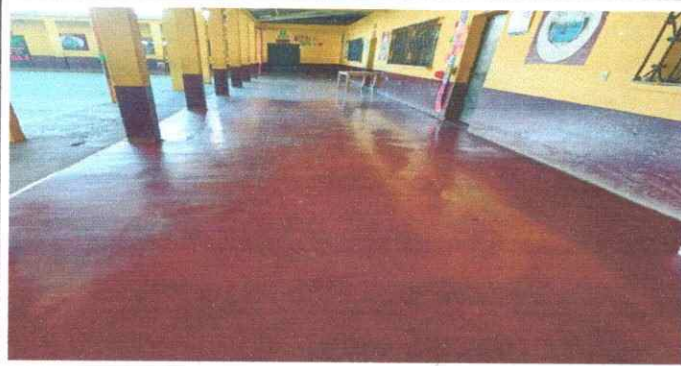
Foto1: Cambio de piso corredor 1
