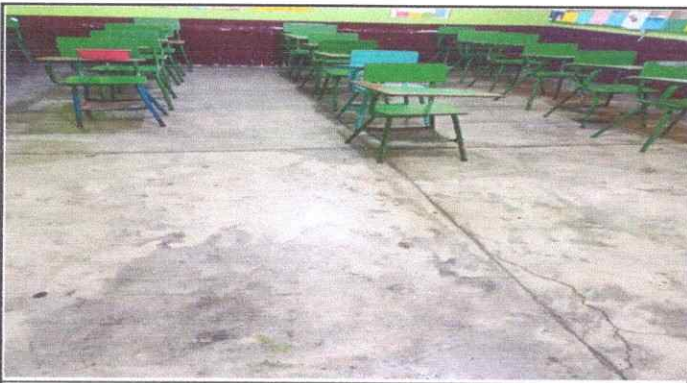
Foto 3: Cambio de piso aulas
