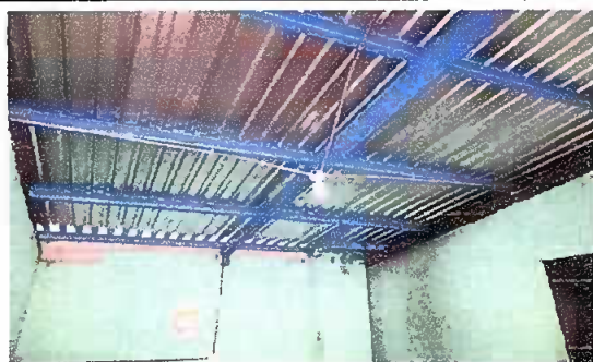
Foto 5: (techo en cocina)
