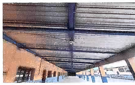
Foto 6: (techo en el pasillo de las aulas)
