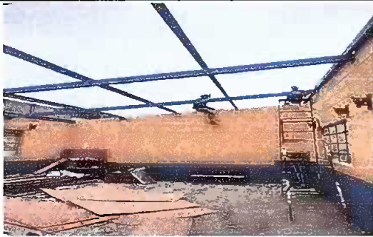
Foto 5: ( Colocación de material en aula)
