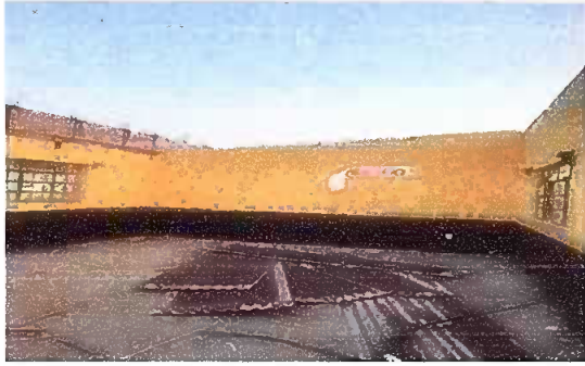
Foto 1: (Desmontado de techo en aulas )
