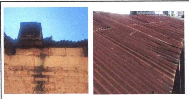
Foto 5: Sustitución de techo (cocina)
