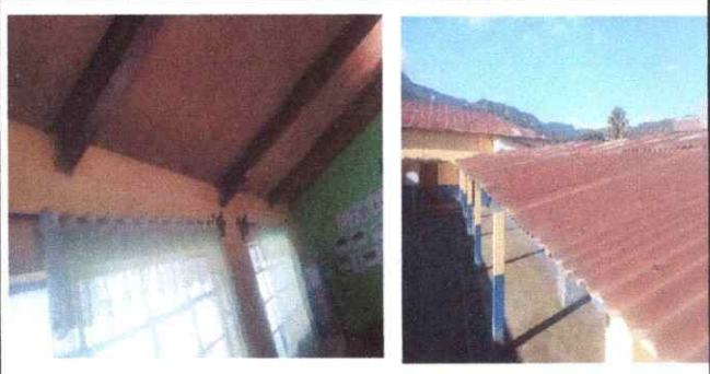
Foto1: Sustitución de techo (Aula No. 1)
