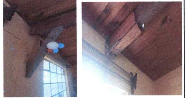
Foto 2: Sustitución de techo (Aula No.2)
