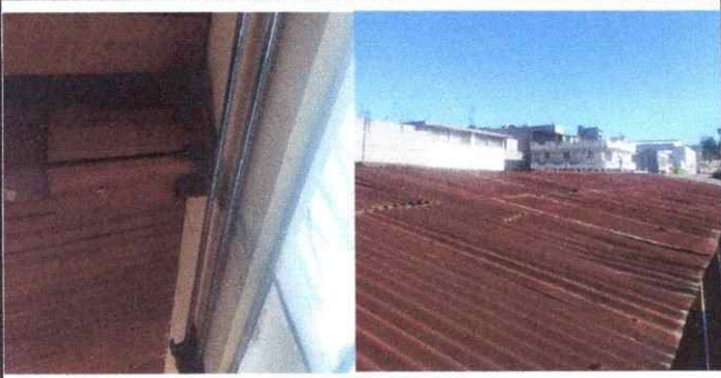
Foto 3: Sustitución de techo (Aula No. 3)
