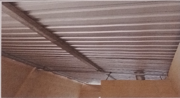
FOTO 1: SUSTITUCIÓN DE LAMINA POR LAMINA
