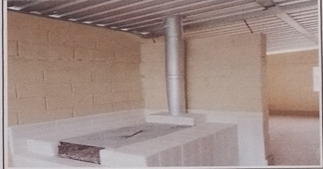
FOTO 2: SUSTITUCIÓN DE CHIMENENA DE METAL UNIDAD
