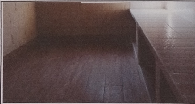
FOTO 5: SUSTITUCIÓN DE PISO DE TORTA DE CONCRETO POR PISO CERAMICO
