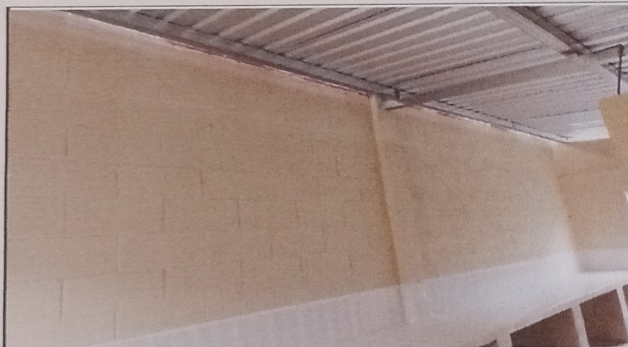
FOTO 9: PINTURA EN INTERIOR DE COCINA
