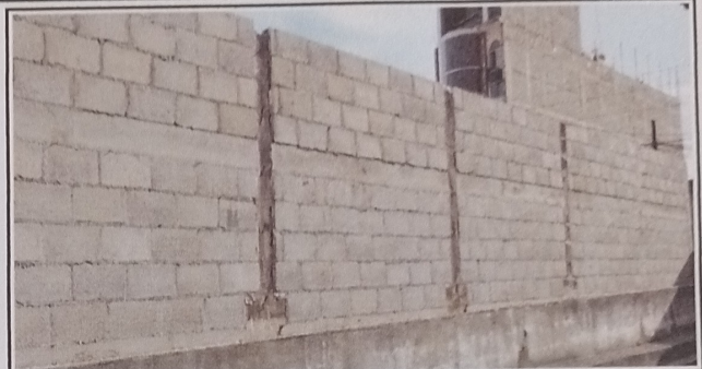
FOTO 8: MURO PERIMETRAL DE BLOCK
