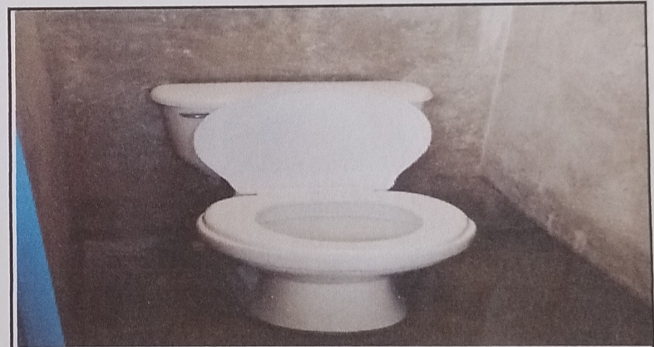
FOTO 10: SUSTITUCIÓN DE INODORO Y ACCESORIOS
