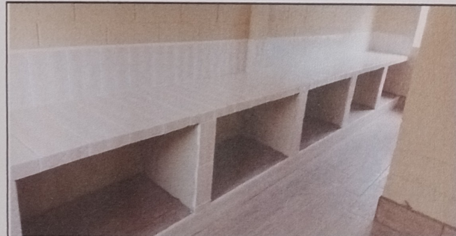
FOTO 6: INSTALACIÓN DE MESA EN COCINA
