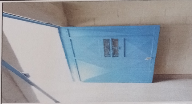
FOTO 7: SUSTITUCIÓN DE PUERTA DE METAL
