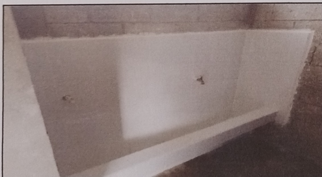
FOTO 11: SUSTITUCION DE AZUQUEJO EN MIGITORIOS Y LAVAMANOS
