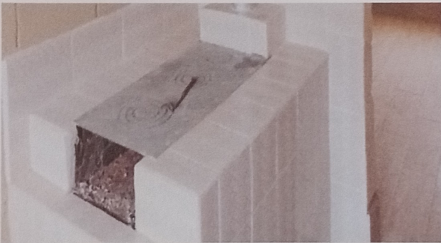
FOTO 3: SUSTITUCION DE PLANCHA DE METAL DE 3 HORNILLAS
