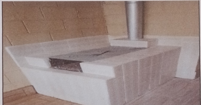
FOTO 4: INSTALACIÓN DE AZULEJO EN ESTUFA
