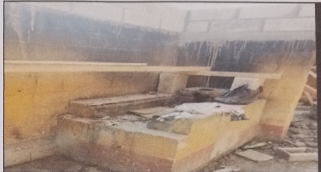
FOTO 2: SUSTITUCIÓN DE CHIMENENA DE METAL UNIDAD
