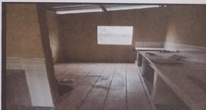
FOTO 6: INSTALACION DE MESA EN COCINA
