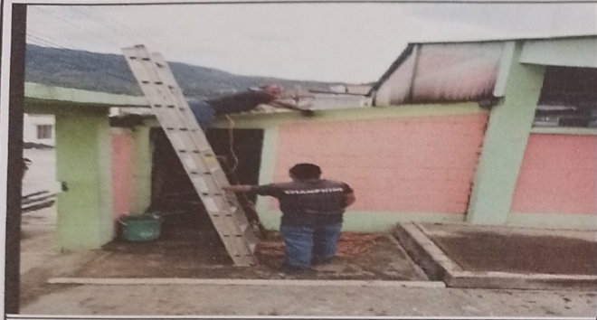
FOTO 1: SUSTITUCIÓN DE LAMINA POR LAMINA
