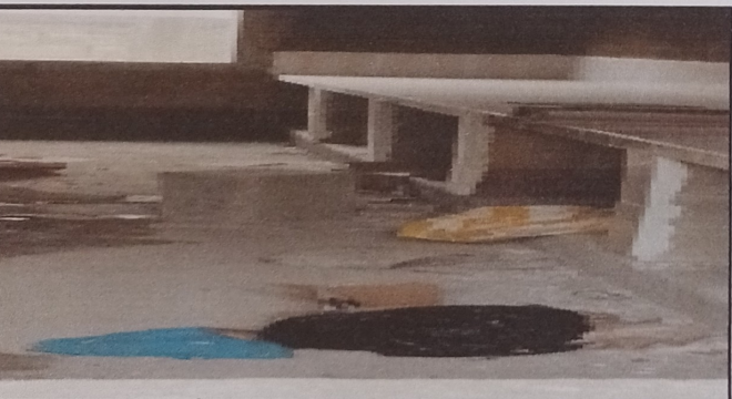
FOTO 5: SUSTITUCIÓN DE PISO DE TORTA DE CONCRETO POR PISO CERAMICO
