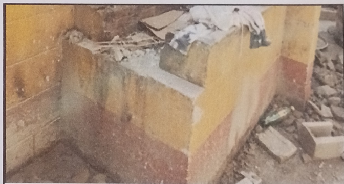
FOTO 4: INSTALACIÓN DE AZULEJO EN ESTUFA
