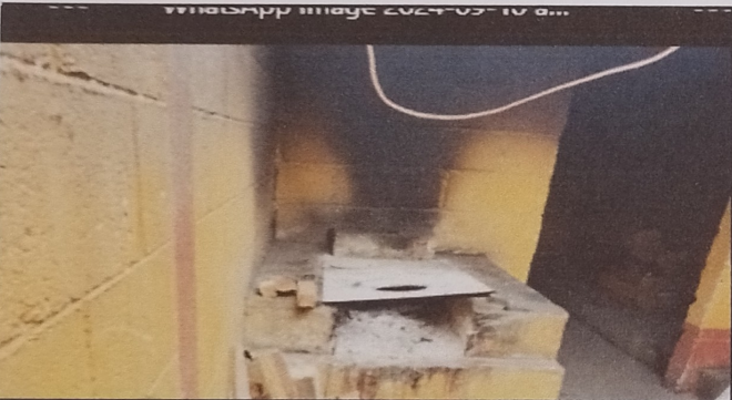
FOTO 3: SUSTITUCIÓN DE PLANCHA DE METAL DE 3 HORNILLAS
