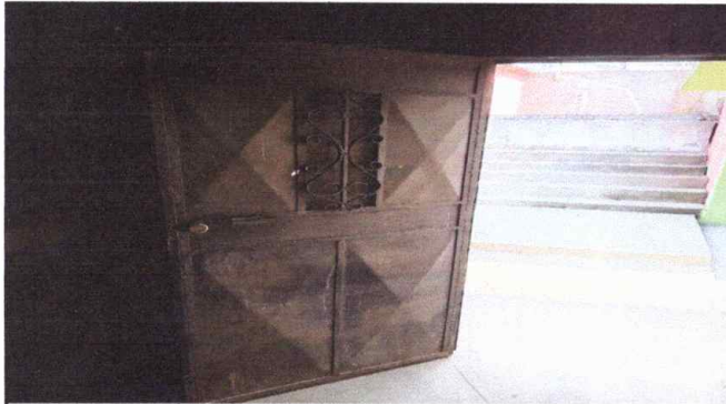
FOTO 7: SUSTITUCIÓN DE PUERTA DE METAL
