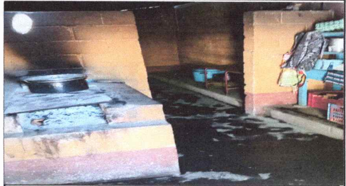
FOTO 8: SUMINISTRO DE TOP DE CONCRETO IN SITU
