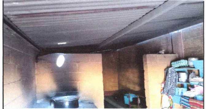
FOTO 2: SUSTITUCIÓN DE CHIMENENA DE METAL UNIDAD
