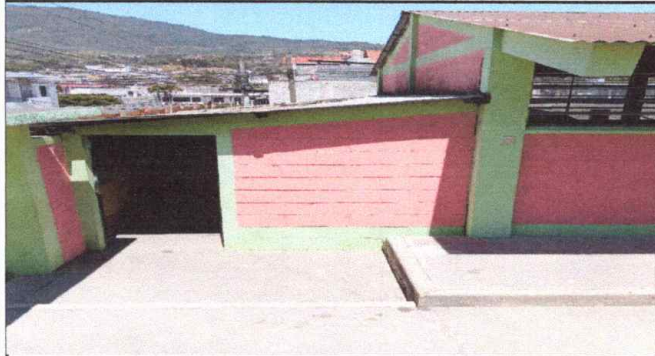
FOTO 1: SUSTITUCIÓN DE LAMINA POR LAMINA EN COCINA
