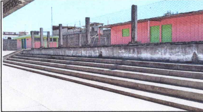
FOTO 14: SUSTITUCIÓN DE PUERTA DE MALLA GALVANIZADA Y REPARACIÓN DE MURO PERIMETRAL DE BLOCK
