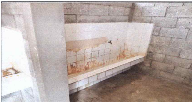
FOTO 10: SUSTITUCIÓN DE AZUÑEJO EN MIGITORIOS Y LAVAMANOS
