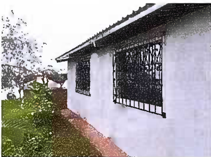
Foto 5: Modulo 1:Mantenimiento de balcones a metal
