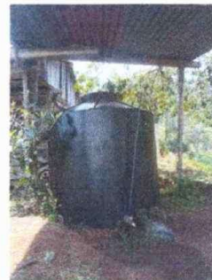
Foto 6: Patio: Sustitución de depósito de agua
