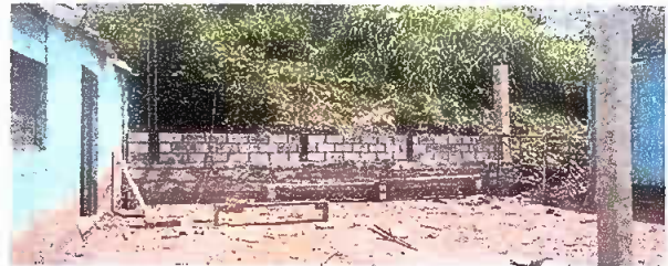
Foto 6: Reparación de muro perimetral de block
