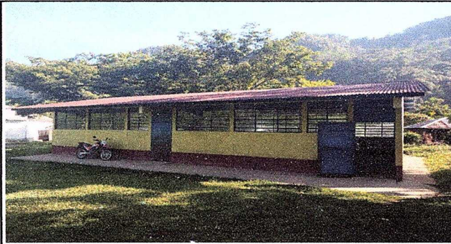
Foto No. 1 MODULO. Sustitución de laminas en mal estado
