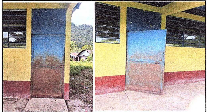
Reparación de de puertas en mal estado
