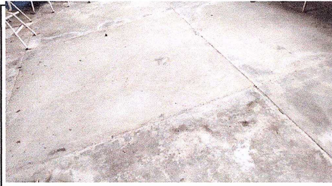
Colocación de piso ceramico.
