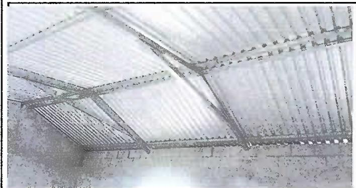
Foto3: Módulo 1 Sustitución de láminas por láminas troquelada
