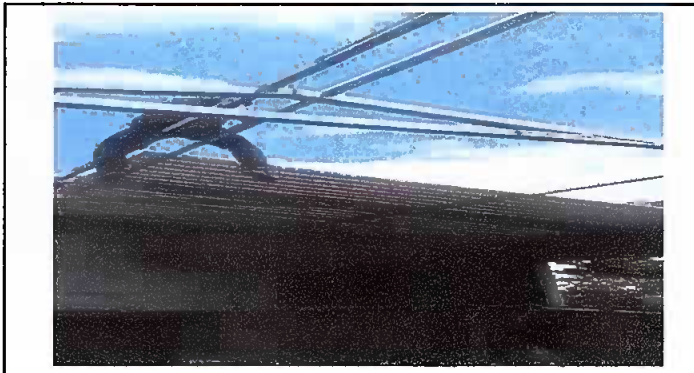
Foto 4: Modulo 1 Sustitución de láminas por láminas troquelada.
