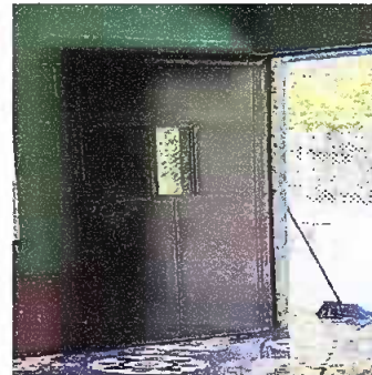
Foto 2, Modulo 1: Suministros e instalación de puertas de metal
