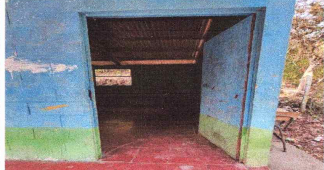
Foto 2, Modulo 1: Suministros e instalación de puertas de metal
